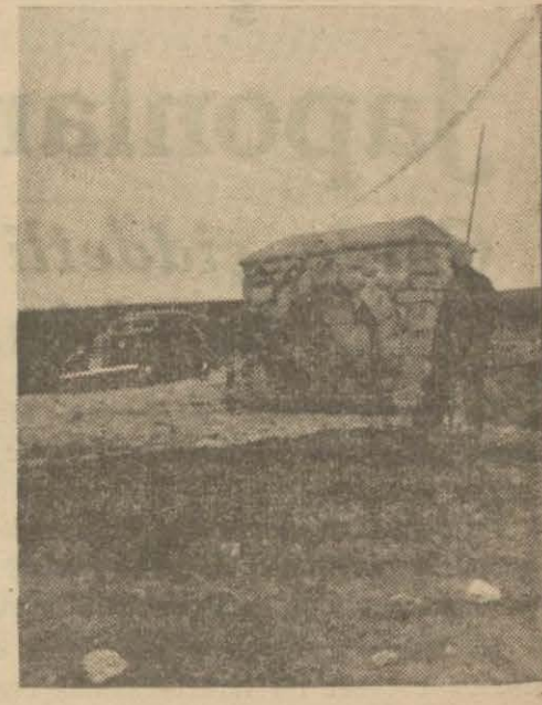
Topkapı - Silivri yolunda tamir edilen çeşmelerden biri
